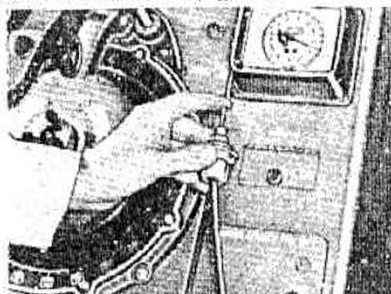
fig. 15 — teste de vazamento na unidade de vácuo
